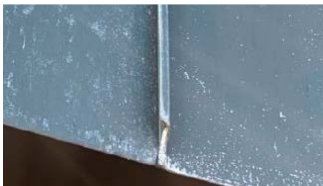
Exemples de dépôts de sel sur les façades, les joints et les égouts
