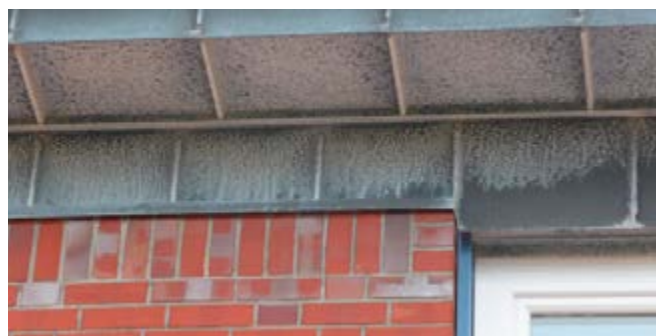
Exemples de dépôts de sel sur les sous-faces et dessous de gouttières
