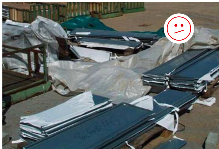
Stockage incorrect sur le chantier
