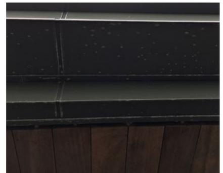
Exemples de dépôts de sel sur les sous-faces et dessous de gouttières
