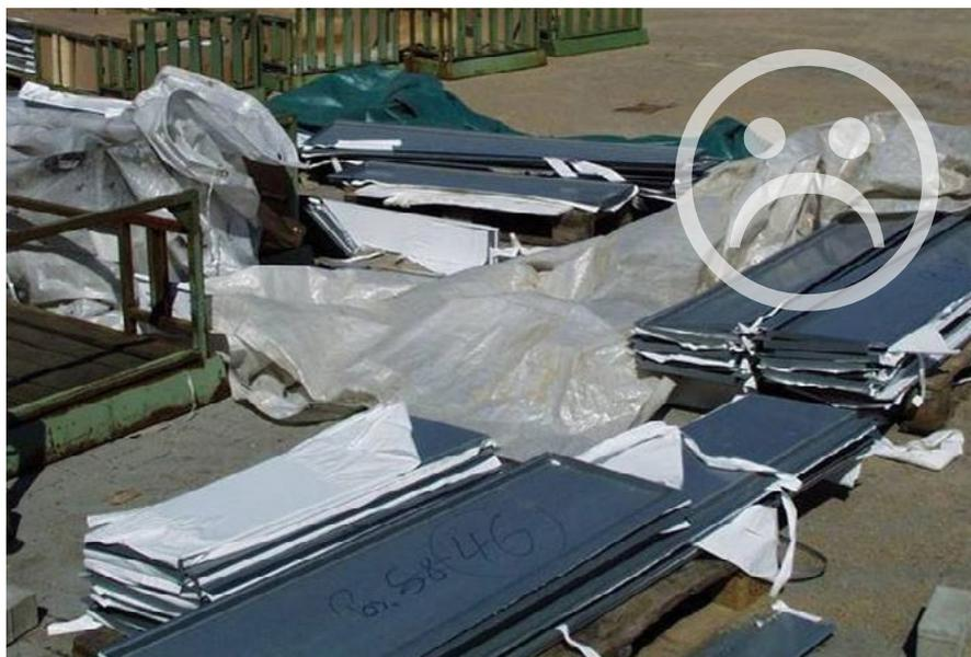
Stockage incorrect sur le chantier
