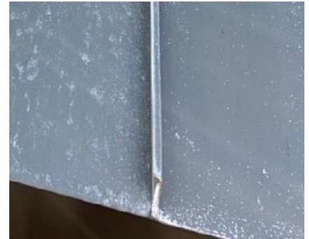
Exemples de dépôts de sel sur les façades, les joints et les égouts
