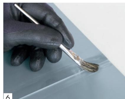
6. Appliquer du liquide à souder Z-04-S au niveau de la jonction à réaliser.
