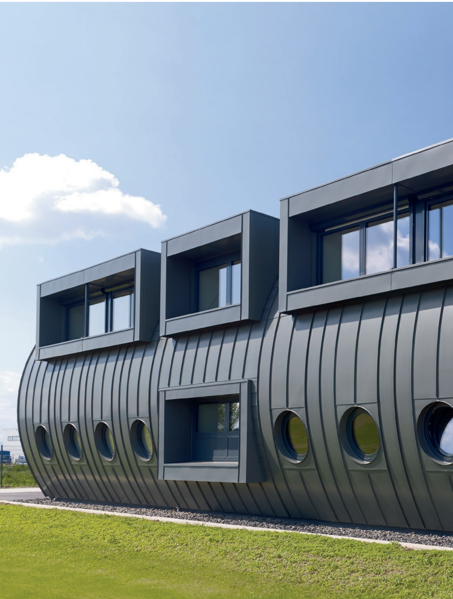
Bâtiment administratif Tecoba, Teningen, Allemagne
