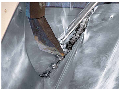
Soudure côté faitage
