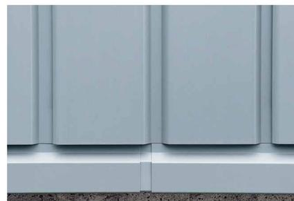
Profilé de pied de bardage avec pièce de raccord
