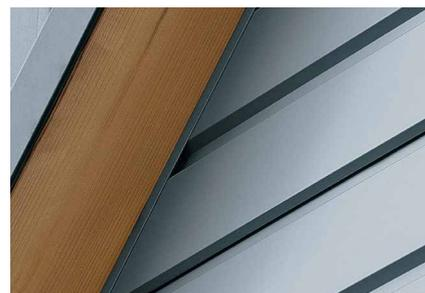
Profilé de raccord entre bardage horizontal et débord de toit
