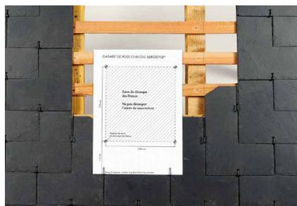
*Facilité de pose grâce au gabarit fourni*
