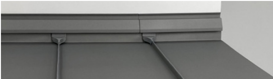
Faîtage ventilé monopente contre mur
