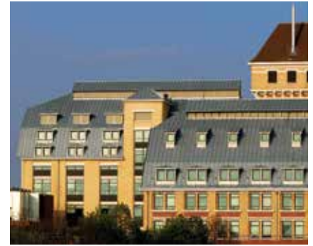
Les Grands Moulins de Pantin, Pantin, France
