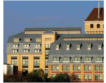
Les Grands Moulins de Pantin, Pantin, France
