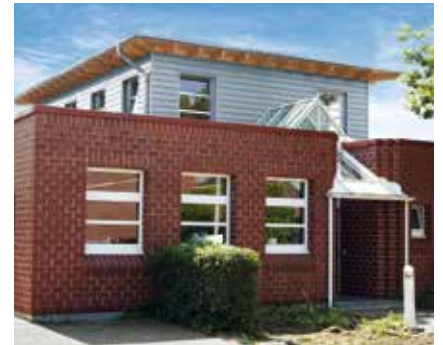
Caserne de pompiers, Dülmen, Allemagne
