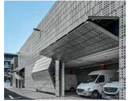
Sous-station de transformation Oerlikon, Zurich, Suisse
